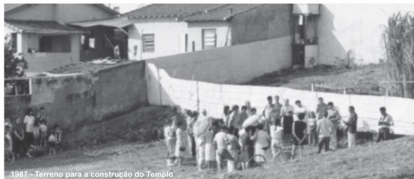
1987 - Terreno para a construção do Templo
